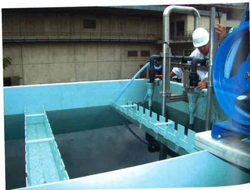
Étude à l'échelle industrielle des performances de traitement des micropolluants par la technologie CarboPlus®, développée par la société Stereau (Saur). Le pilote a été installé et suivi pendant 5 ans au rejet de la station Seine Centre du SIAAP (Haut-de-Seine, 800.000 eq.hab).
